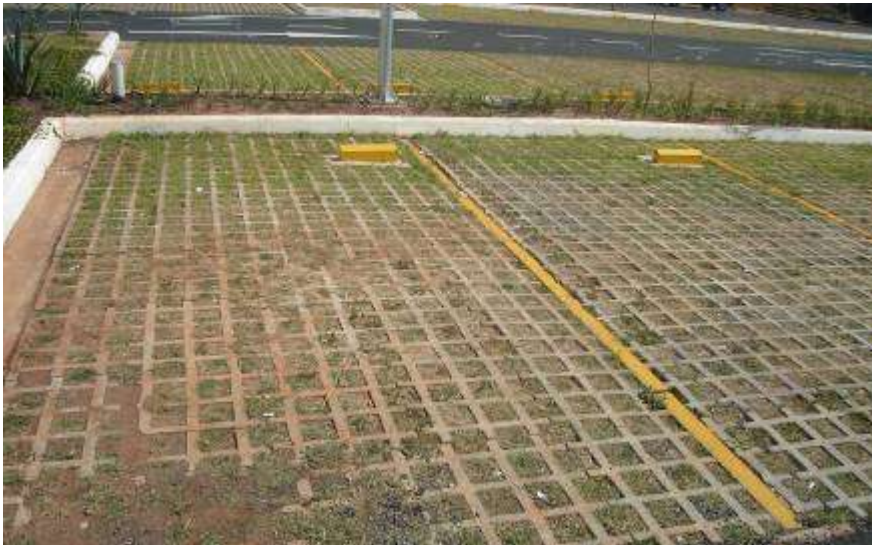
Vagas do estacionamento confeccionadas em concregrama.
